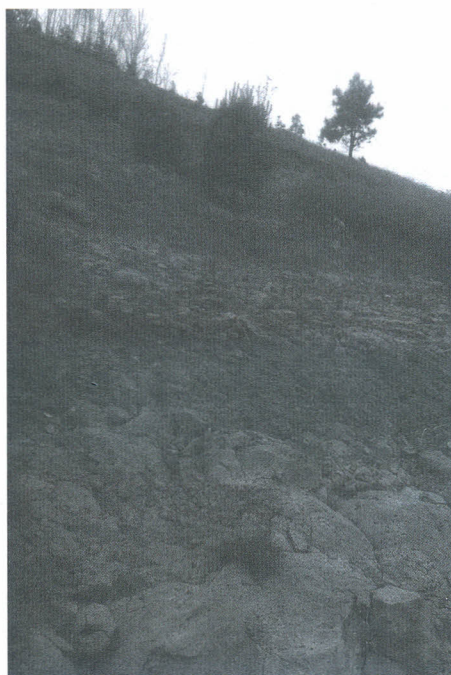
Fig.1 - Deslizamento de terras ocorrido no temporal do 20 de Fevereiro de 2010, Sítio do Pastel, Serra de Santo António (Junho de 2014).
